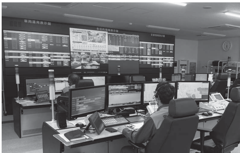
高機能消防指令センター
