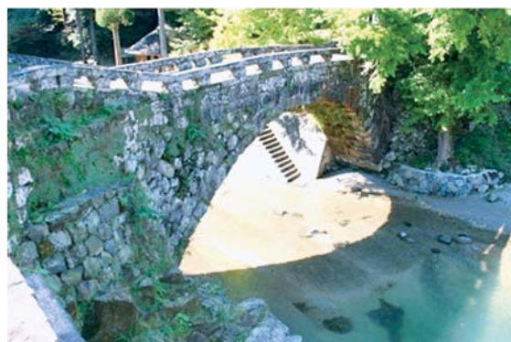
▲美里町・二俣橋のハート
