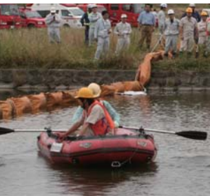
吸着マットの回収作業
