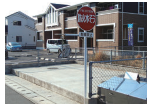
防火水そうと標識
