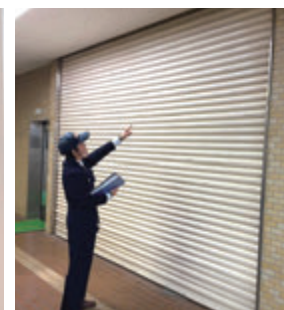
⑤ 防火シャッター
