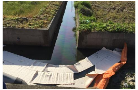
「オイルフェンス及び吸着マットを使用した回収作業」
